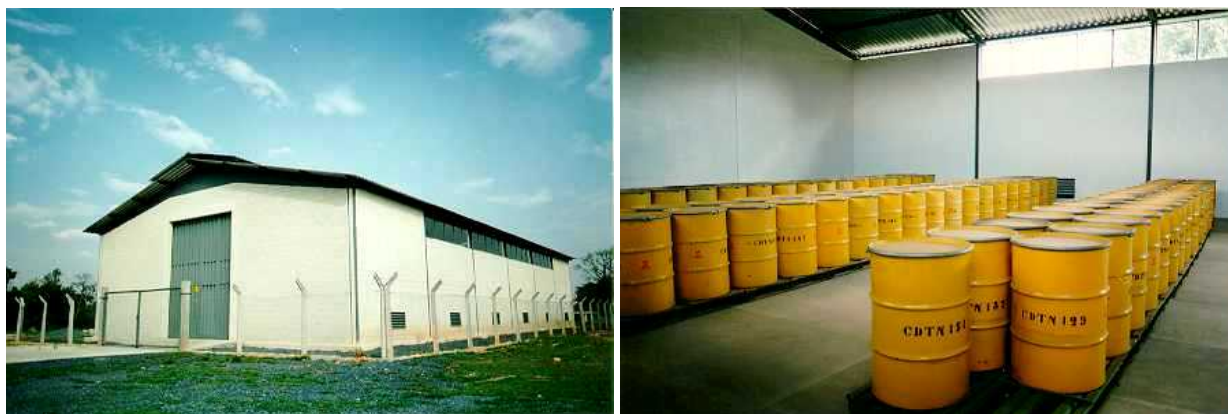
Figura 7 – Galpão de armazenamento provisório (CDTN/CNEN)
