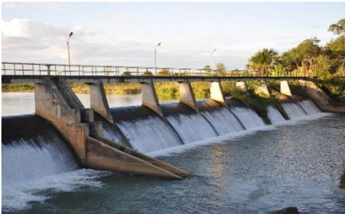
Figura 25. Vista longitudinal do vertedor da PCH Pandeiros funcionando como uma cachoeira
