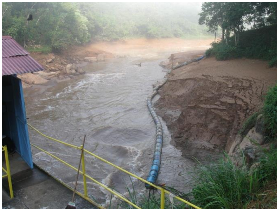
Figura 30. Vista para montante da barragem da PCH de Paciência, em descarga de fundo.
