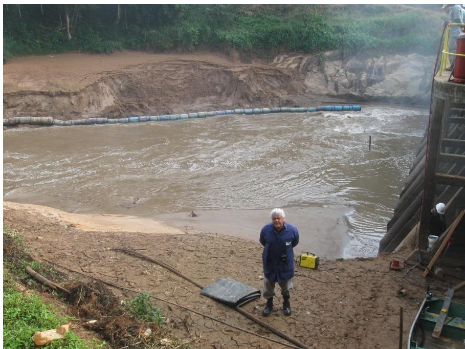
Figura 31. Vista lateral da barragem da PCH de Paciência, em descarga de fundo.
