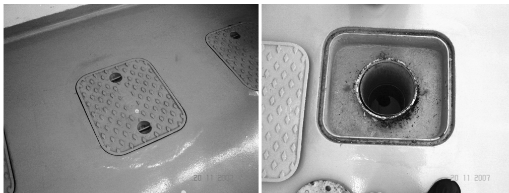
Fig. 2. Poços de estocagem de elementos combustíveis irradiados.
