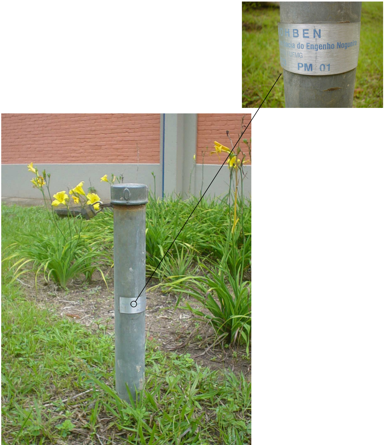
Figura 6.5 – Poço de monitoramento (PM01) Bacia do Ribeirão Engenho Nogueira (PROHBEN)
