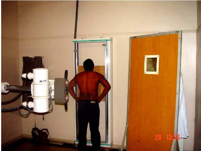
FIGURA 12 – Sala de exames radiológicos com um biombo de chumbo à direita protegendo o operador.
