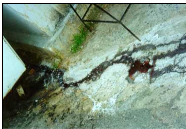
Figura 29 - Vazamento de chorume de dentro do contêiner
