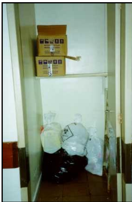
Figura 28 - Sala de resíduo existente no segundo andar do HCF
