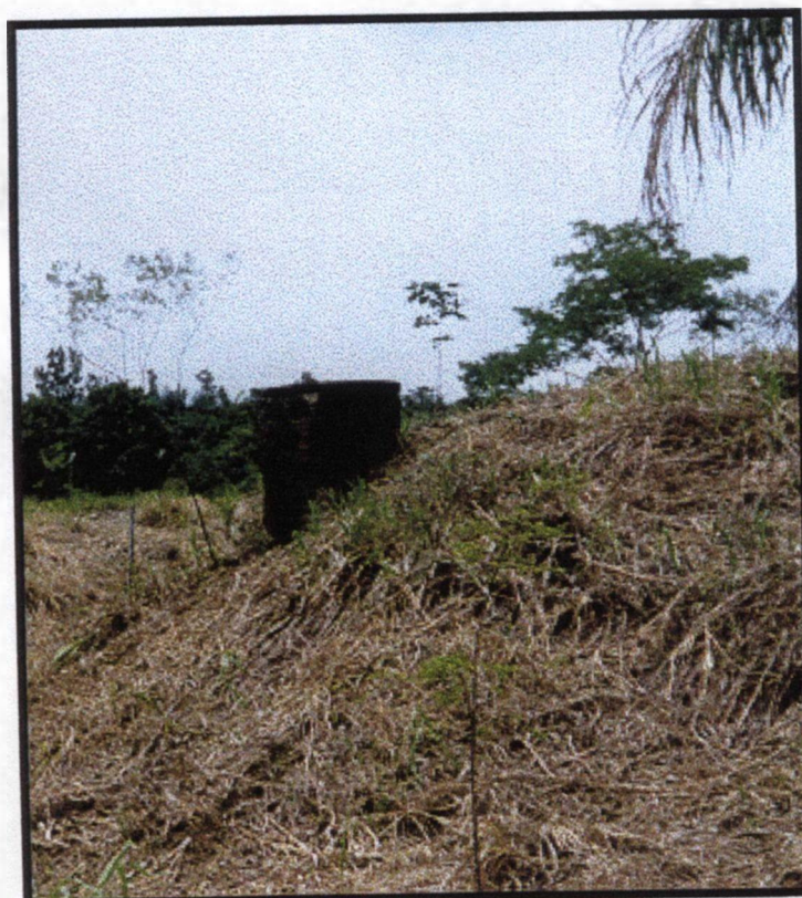
Foto 17: Observa-se o poço de visita ao subsistema de drenos CDTN-Reitoria. (jul./1997).
