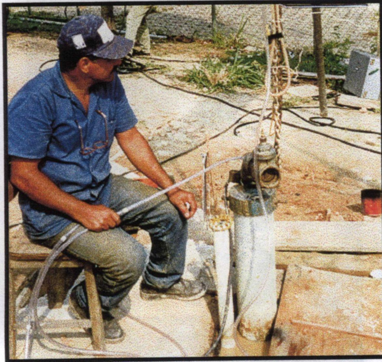
Foto 14: Realização de ensaio de recuperação no poço tubular P5. (set./1995).
