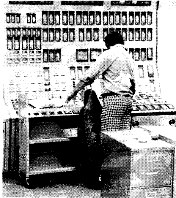
Figura 2.5-5 - Boa solução ergonômica, com procedimento transportado por carrinho de mão [16]
