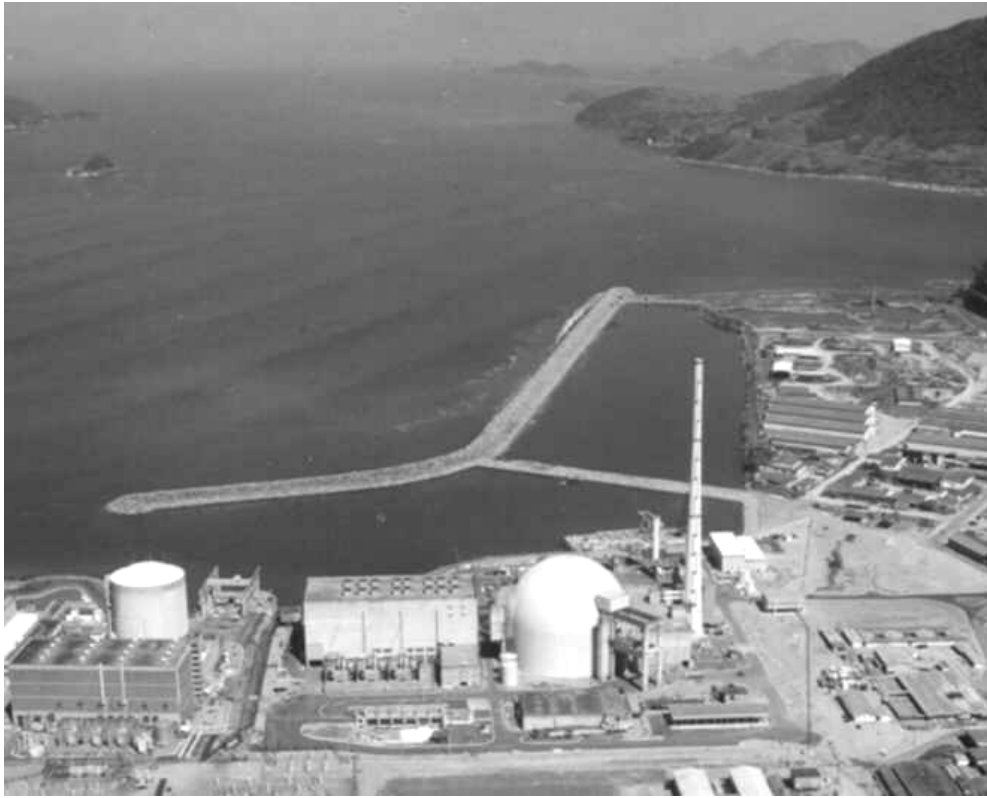
Figura 1.1 - Vista do sítio das Centrais Angra 1 e 2 Fonte: www.eletronuclear.gov.br
