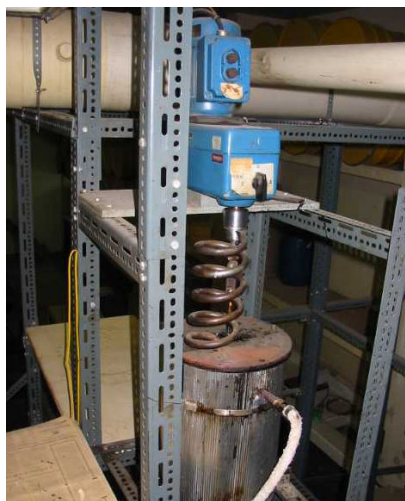
Figura 4.13 Tanque de betume com misturador-agitador
