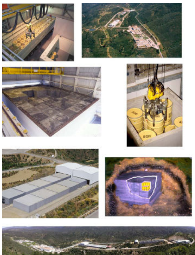
Figura 3.1 Depósito de rejeitos radioativos da Espanha - El Cabril (ENRESA, 2006)
