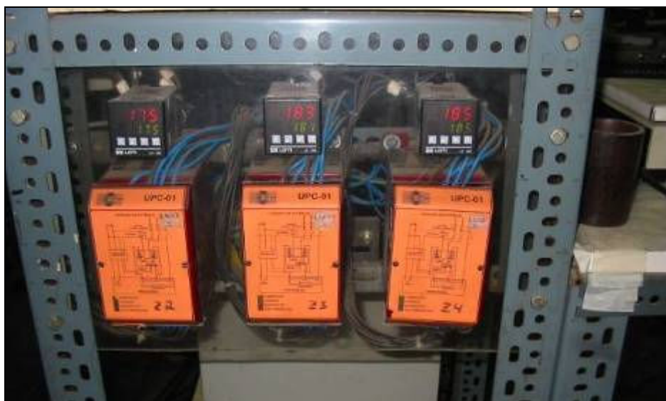
Figura 4.15 Unidades de potência para o sistema de betuminização
