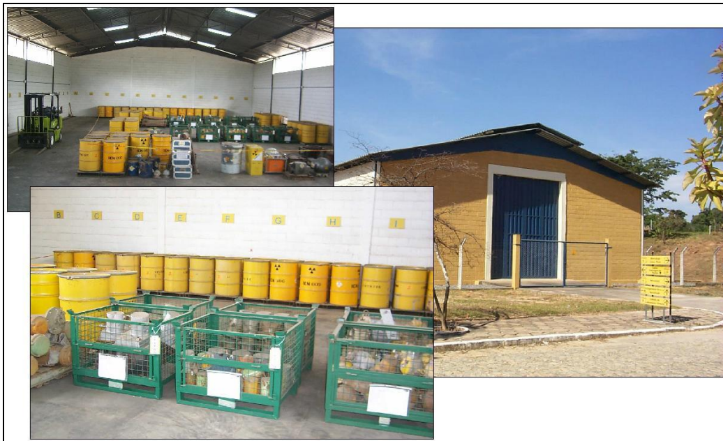
Figura 3.46 - Depósito de rejeitos radioativos e de FFU do CDTN.
