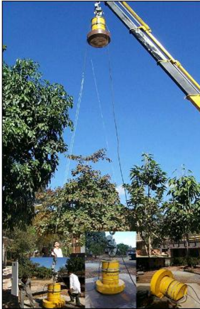
Figura 3.54 - Instalação de teste de queda livre para embalados Tipo B no CDTN.
