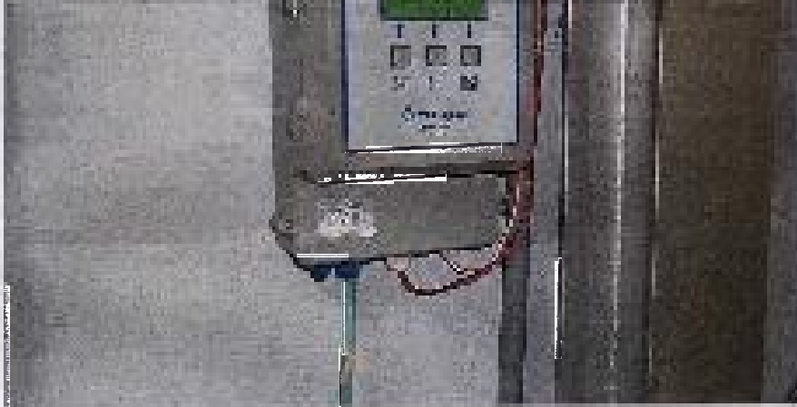
Medidor de Vazão por Efeito Coriolis
