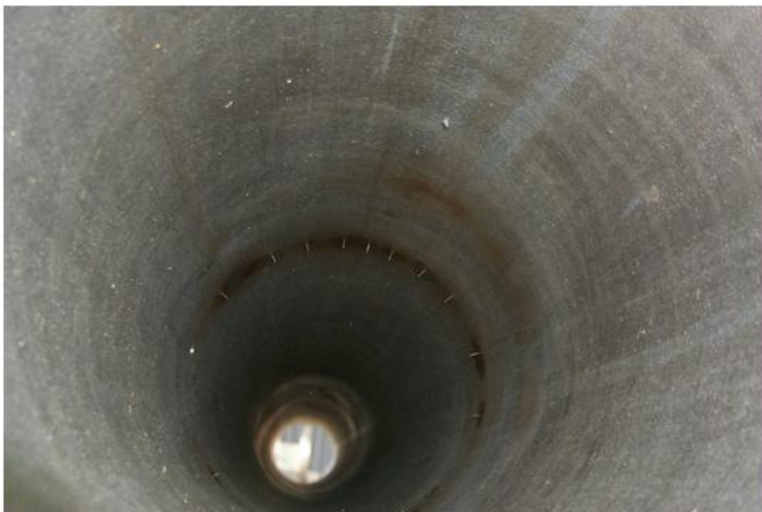
Figura 3.14 – Detalhe dos termopares de fluido da Estação de Medição 1, vistos do interior da seção de testes.
