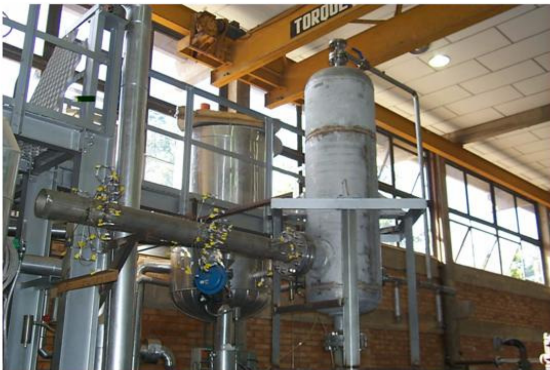
Figura 3.15 – Vista parcial do DTLES durante a montagem da seção de testes de estratificação térmica.
