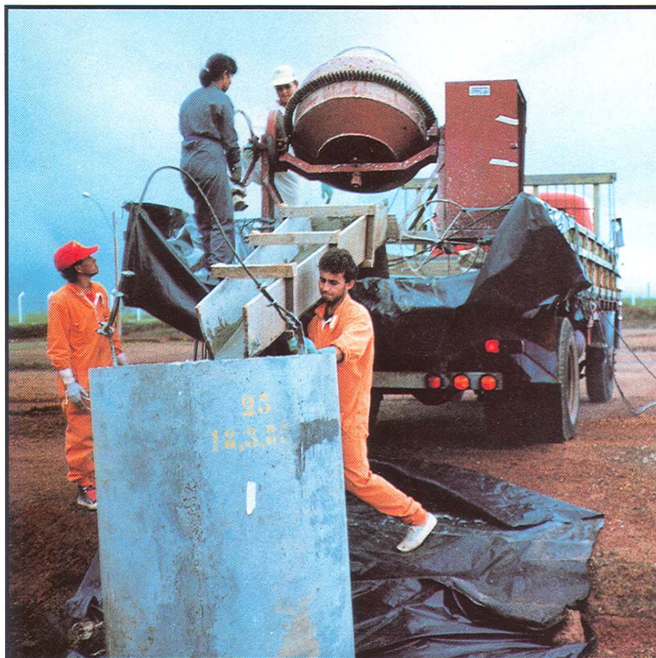
Fig. 5: Solidificação de rejeitos radioativos utilizando uma unidade móvel
